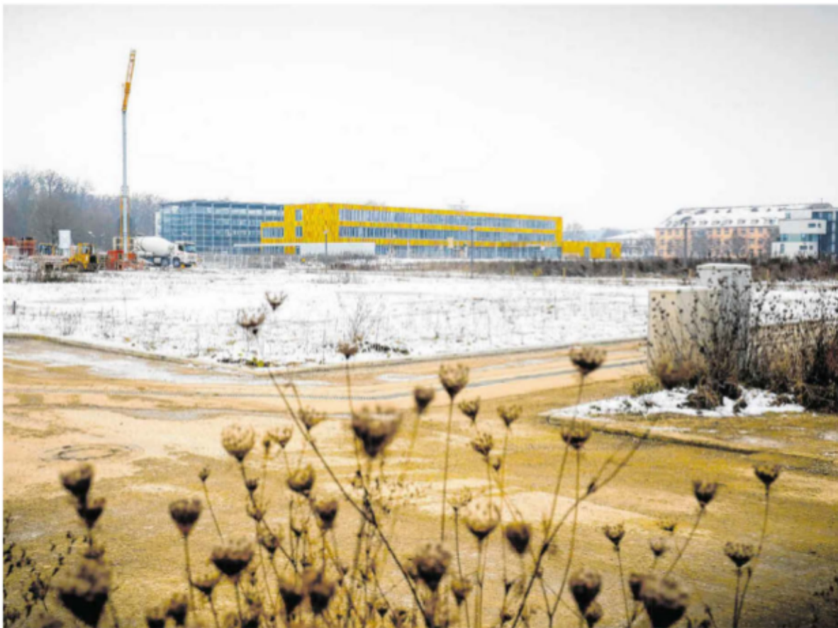
Baugrund an der Curd-Jürgens-Straße: Hier soll das Mehrgenerationenhaus von Mitgliedern der Friedenskirche entstehen. Im Hintergrund die Mark-Twain-Grundschule, rechts davon soll der Neubau des Lesing-Gymnasiums entstehen. Foto: Matthias Kessler
